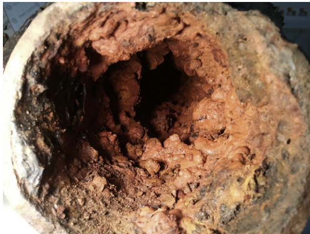
Rys. 13. Zdjęcie wnętrza skorodowanego przewodu żeliwnego [46].
